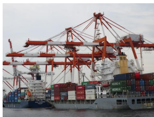
ガントリークレーンで荷役中の船（本牧ふ頭）
